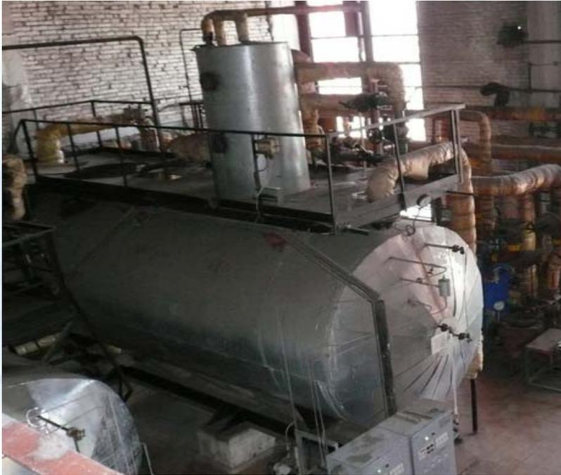
*Морально устаревшие котлы не оборудованы системой регулирования по температуре наружного воздуха, или, как сейчас говорят, с погодозависимой автоматикой, и работают с крайне большой температурой воды на подаче (80 градусов и выше). Современное низкотемпературное оборудование исключает данный недостаток, а также предлагает целый ряд энергосберегающих вариантов по регулировке системы отопления.*
